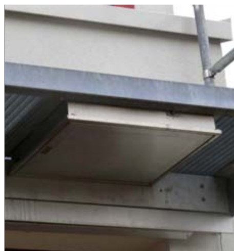
La pose s'effectue dans une trémie rectangulaire adaptée ou coulé dans le béton du sol.
